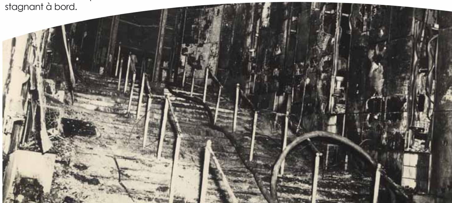
Les superstructures furent rasées au-dessus du pont principal, afin d'abaisser le centre de gravité du navire. Il fallut ensuite rendre la coque étanche, en bouchant la totalité des hublots immergés et en refermant les sabords laissés ouverts sur bâbord. Puis on commença à pomper, et *Normandie* se redressa. Le 15 novembre 1943, ce qui restait du grand paquebot put quitter le pier 88.
