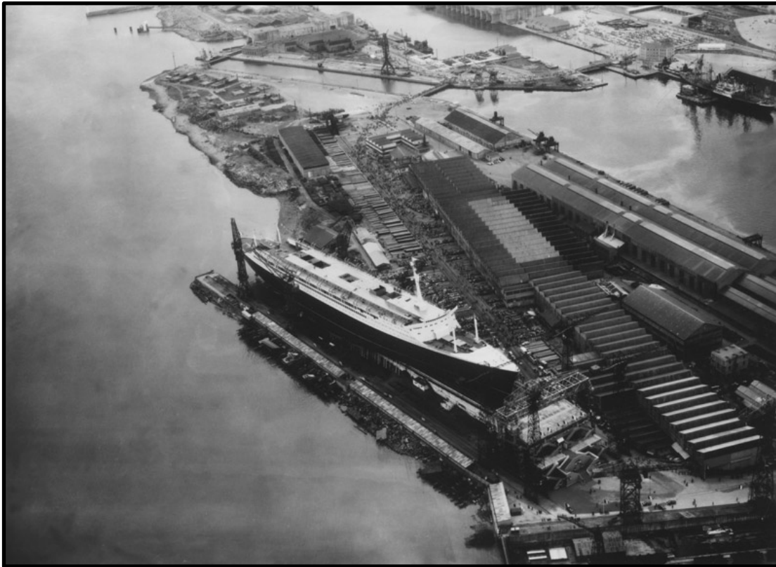
Saint-Nazaire, France en construction, 10 mai 1960
