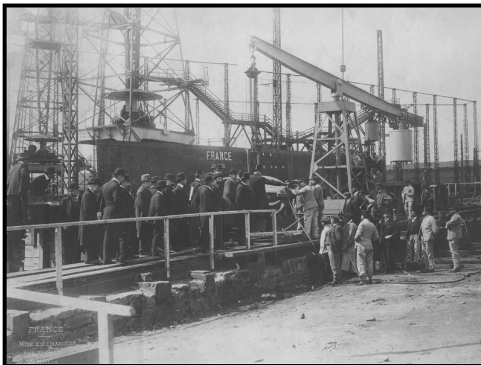
La mise en chantier du France fut lancée le 20 avril 1909.
